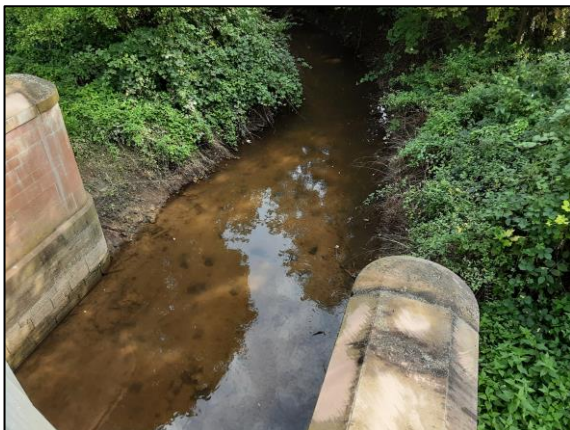
Abbildung 35: Trompetergraben, zwischen Trommelweg & An Fronte Karl
