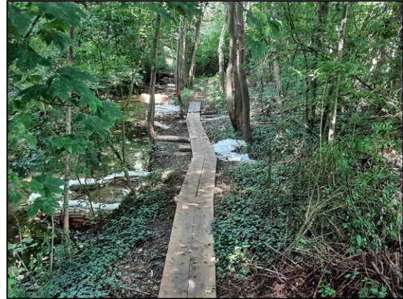
Abbildung 25: öffentliche Ortsbegehung 07.09.2021; Abdichtung Rheinhauptdeich
