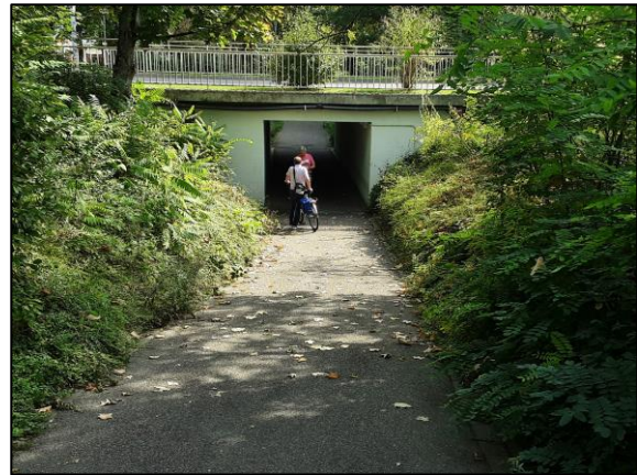
Abbildung 54: Unterführung an der Josef-Probst-Straße
