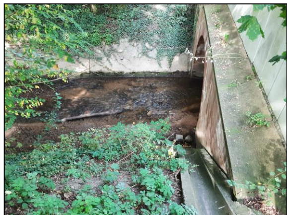
Abbildung 34: Trompetergraben, Brücke Waldstraße
