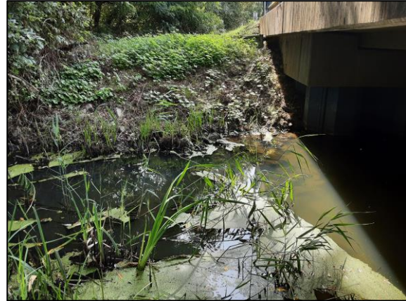
Abbildung 38: Gimpelrheingraben, Brücke Konrad-Nolte-Straße
