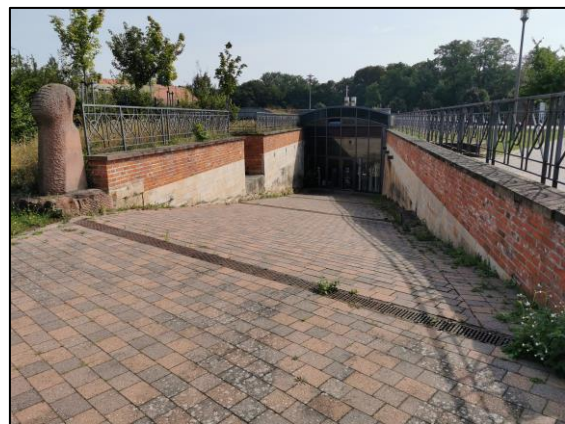
Abbildung 48: Tieferliegender Eingangsbereich – Stadtpark Fronte Lamotte
