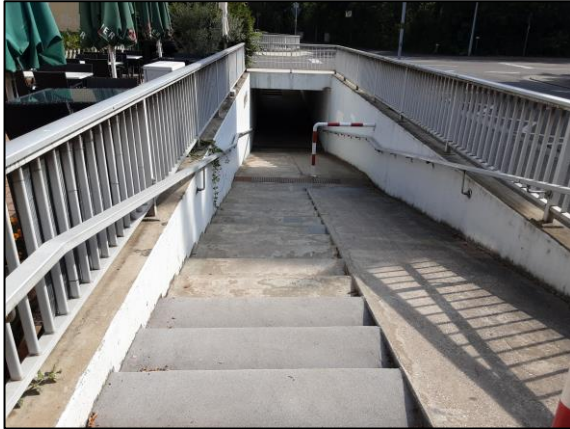
Abbildung 24: öffentliche Ortsbegehung 07.09.2021; Unterführung Josef-Probst-Straße
