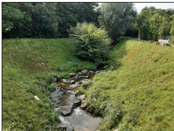
Abbildung 16: öffentliche Ortsbegehung 07.09.2021, Fischaufstiegshilfe/Fischtreppe Queich, Thomas-Dehler-Straße
