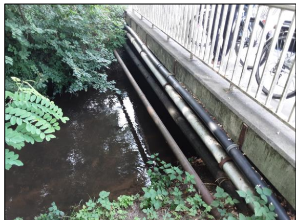
Abbildung 23: öffentliche Ortsbegehung 07.09.2021; Queich, Josef-Probst-Straße
