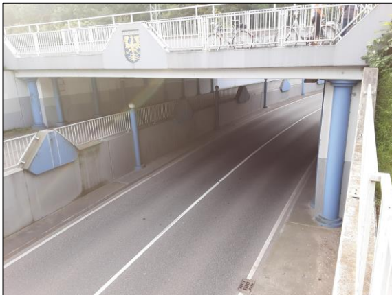
Abbildung 51: Unterführung an der Rheinbrückenstraße
