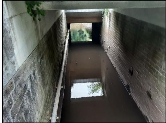
Abbildung 32: Queich, Unterquerung der Bahnschienen
