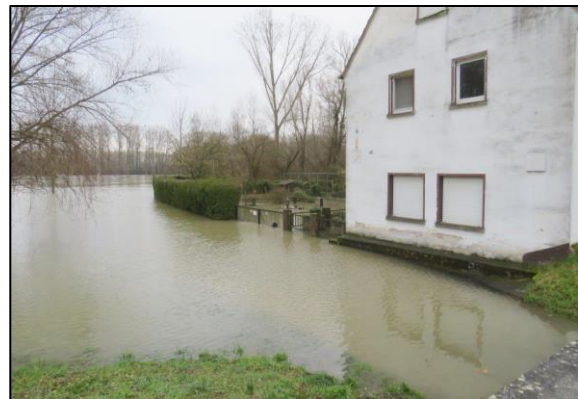
Abbildung 5: private Aufnahme – Hochwasser im Bereich Hans-Mayer-Str. 15
