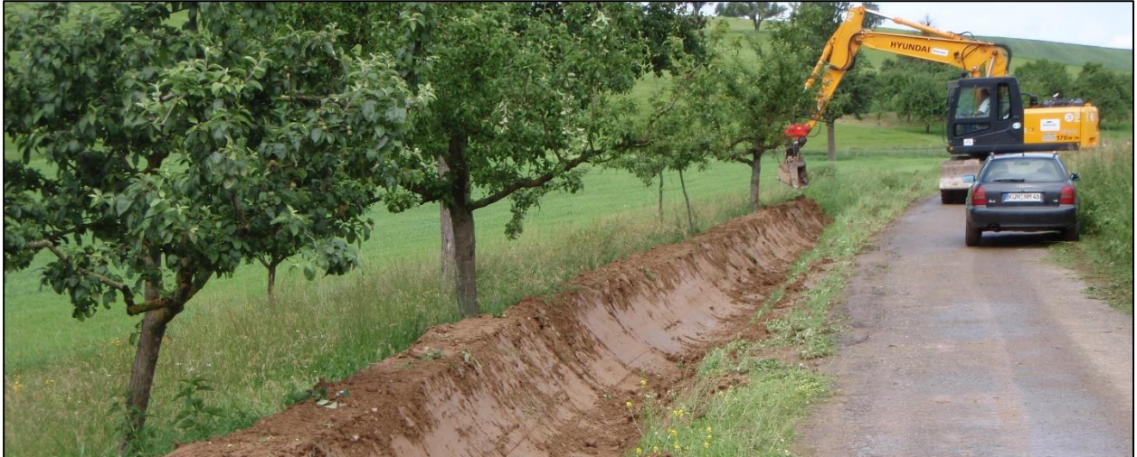
Abbildung 60: Unterhaltungsarbeiten an einem Grabensystem
