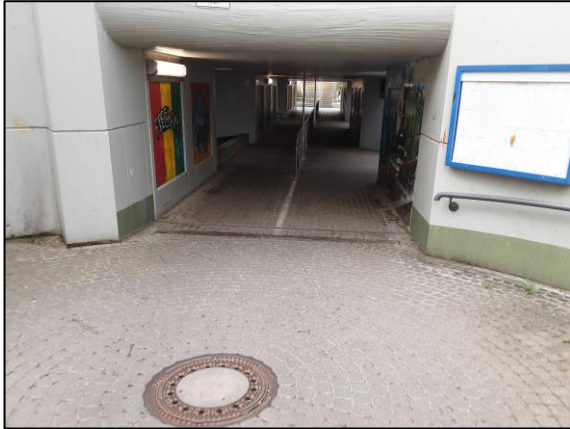
Abbildung 18: öffentliche Ortsbegehung 07.09.2021, Bahnhof Germersheim, Unterführung mit Zugang zu Gleisen
